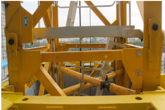
顶部附着框处安装内撑杆
