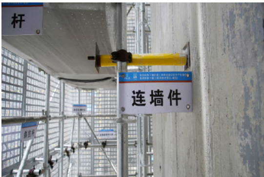
盘扣钢管脚手架连墙件
