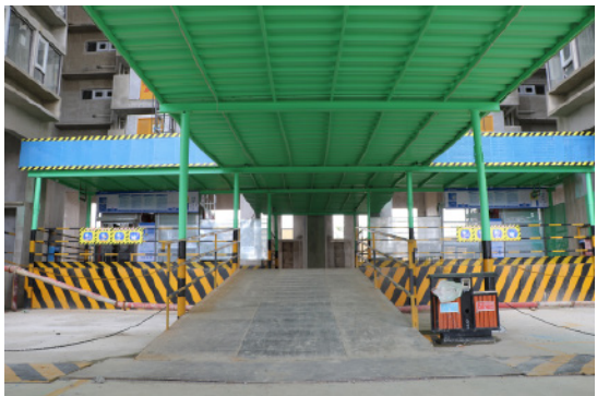
施工升降机出入口防护棚
