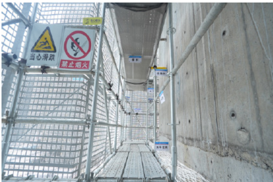
盘扣钢管脚手架走道板
