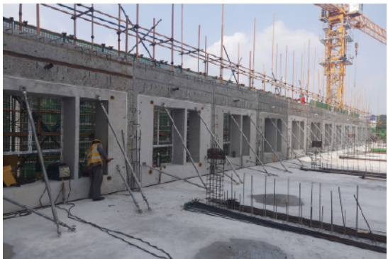
构件固定和临时支撑
