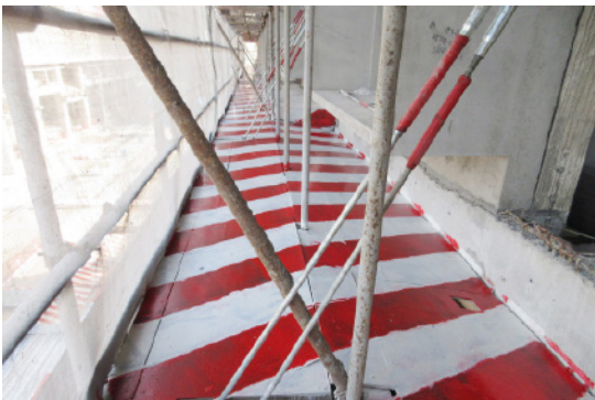
悬挑层封闭及卸荷
