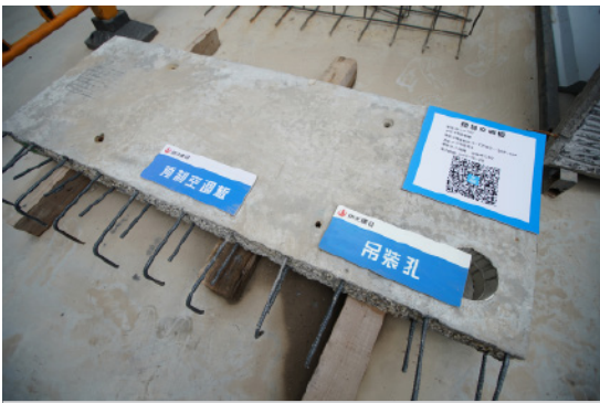
预制构件吊装孔
