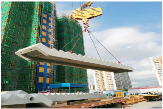
楼梯构件吊装
