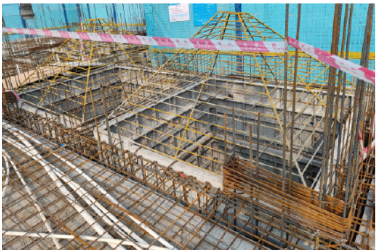
铝模作业层电梯井防护
