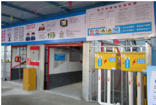
施工梯首层防护及电箱设置
