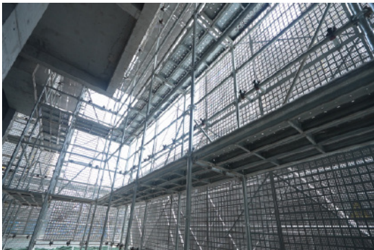
盘扣钢管脚手架架体
