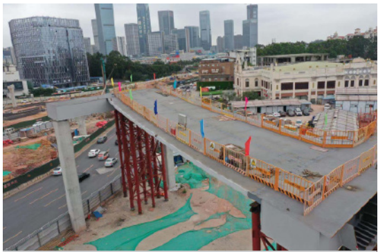
桥面施工及临边防护
