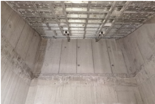
电梯井内水平防护
