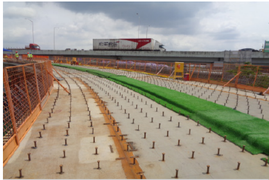
作业面水平通道及两侧临边防护
