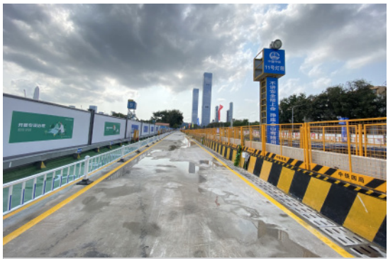
人车分流及基坑防护
