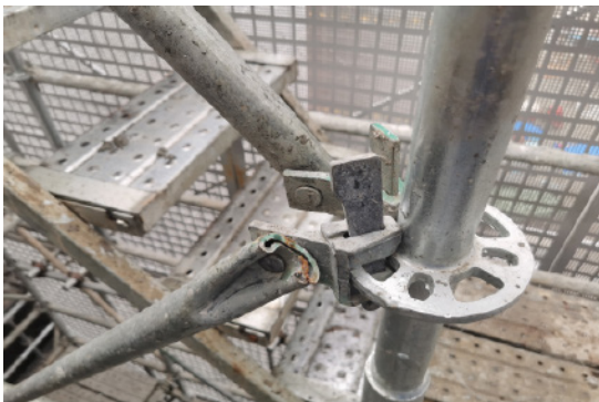
盘扣式钢管脚手架节点图
