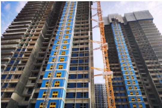
施工梯层门防护外观
