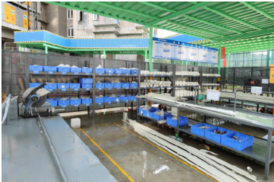
水电材料堆放区
