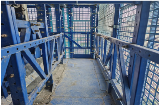
首层走道及双侧水平桁架
