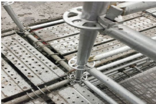
盘扣式钢管脚手架节点图
