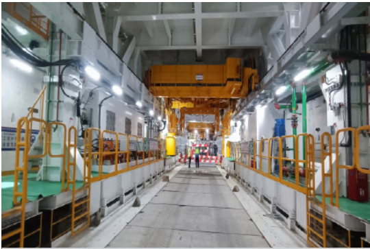
盾构机后配套台车
