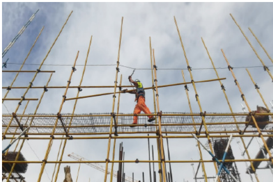
脚手架顶部设有生命绳
