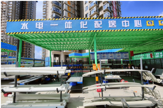
水电材料堆放区
