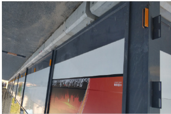
围挡安装反光警示灯
