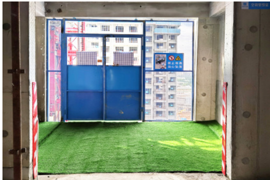
施工梯层门防护
